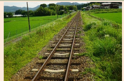
軌道強化（PC枕木への改良）
