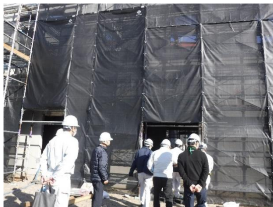
〔 道の駅あいの土山新築工事 〕
