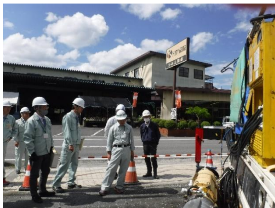
〔 公共下水道長野地区管渠整備工事その１４ 〕
