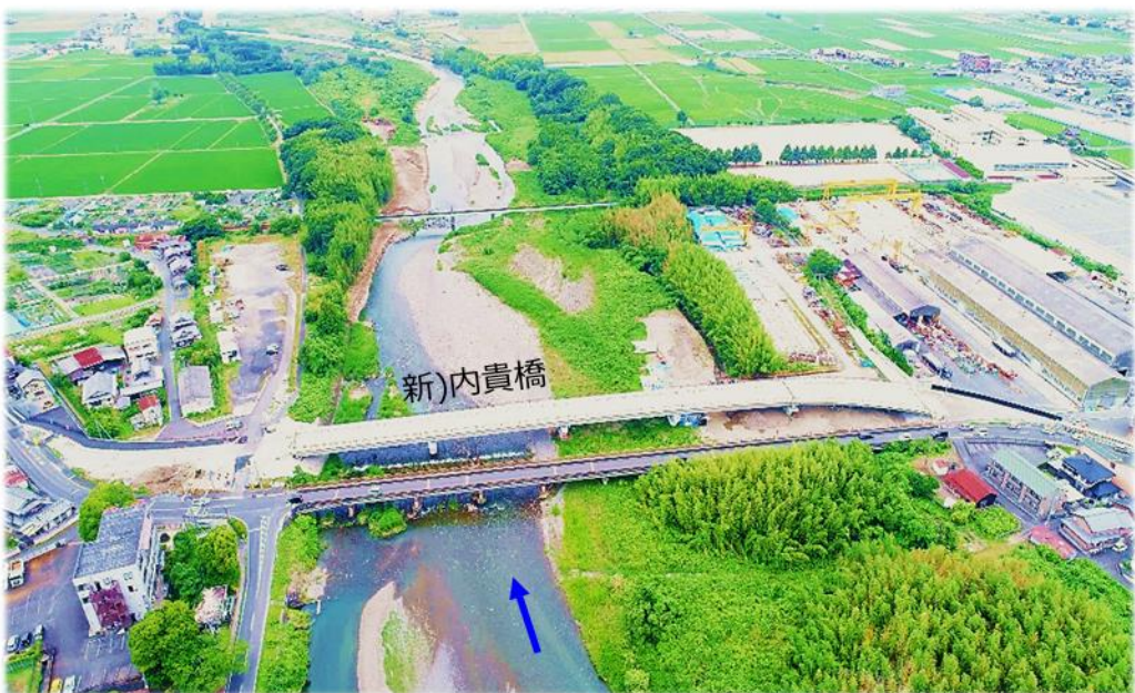
市道新町・貴生川幹線 内貴橋 (左(左岸)水口町北内貴、右(右岸)水口町水口)
