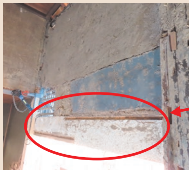
▲写真3 修理途中の玉座西面壁
