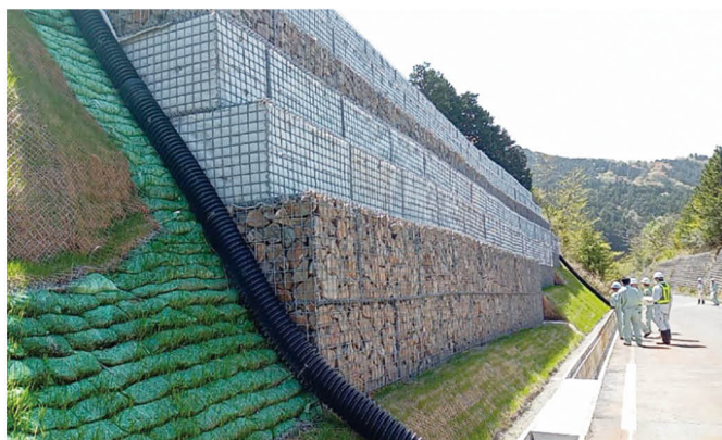
市道南土山・神線の復旧現場
