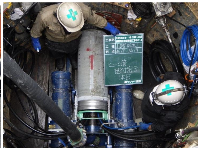
写真一 8 工事現場施工状況 (管推進工 No.18→No.17)
