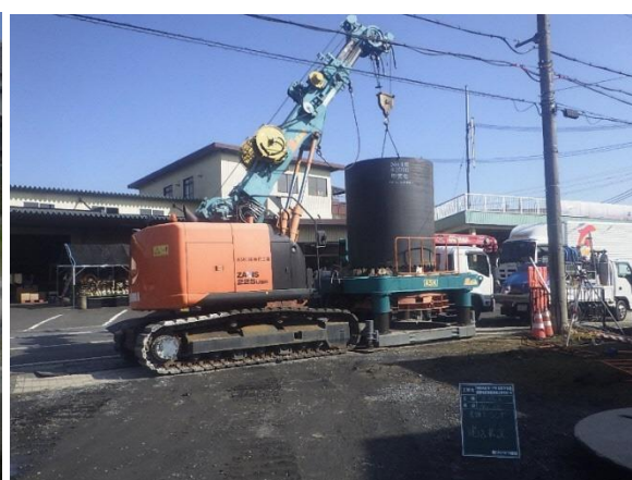
写真-6 工事現場施工状況 (立坑築造工 No.18)
