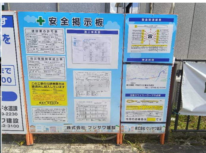
写真一 10 工事標示板設置状況 (施工体制・連絡網等)
