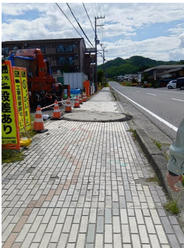
写真一 9 工事現場施工状況 (立坑 No.18→No.19 方面)
