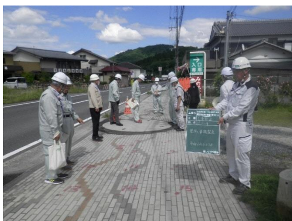
写真-5 工事現場立会状況 (歩道・立坑付近)
