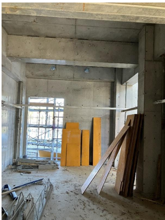
2 工区：1 階物販倉庫スペース
