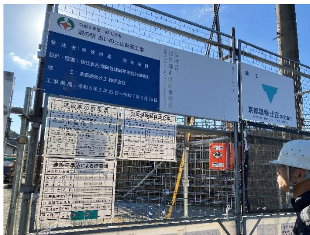
建設業許可、労災保険など掲示板
