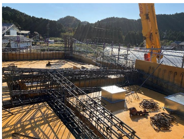
1 工区：2 階 梁配筋済
