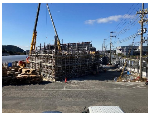
工事現場全体
