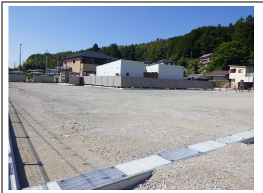
施設全景（東側から・舗装工事前）
