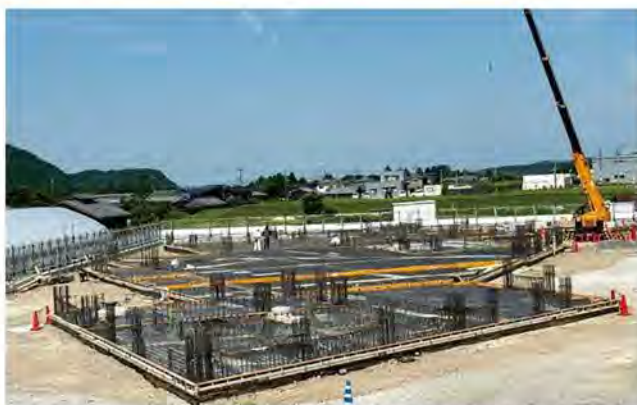
道の駅あいの土山 現場状況（令和6年8月9日現在）
