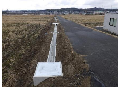
▼用水路の整備
