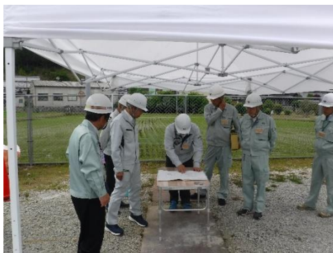
〔 中野浄水場施設更新工事その2 〕
