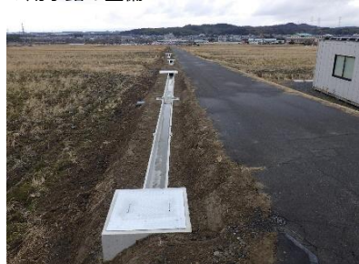
▼用水路の整備
