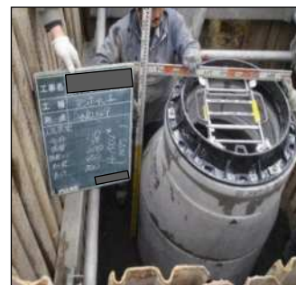
管路施設整備の状況
