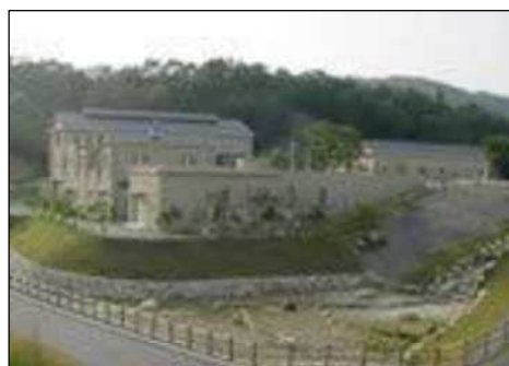
甲賀市信楽水再生センター
