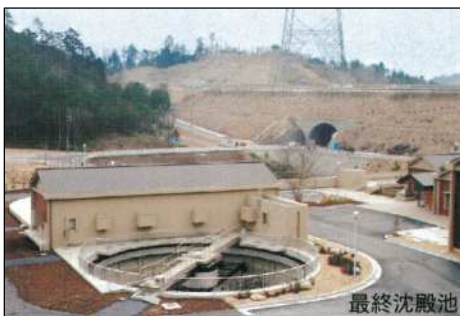
甲賀市信楽水再生センター
