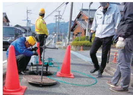
▲カメラによる下水道管緊急点検の様子
