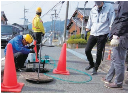
▲カメラによる下水道管緊急点検の様子
