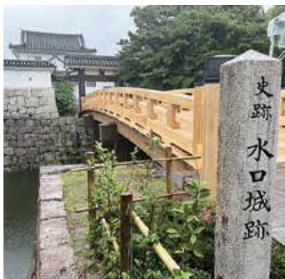
完成した水口城跡御成橋
