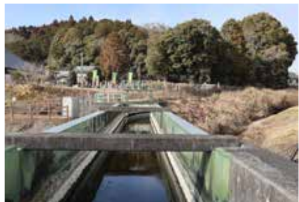
写真 64 用水路トンネル
