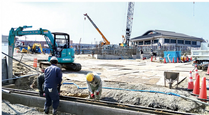
改築工事が進む信楽小学校
