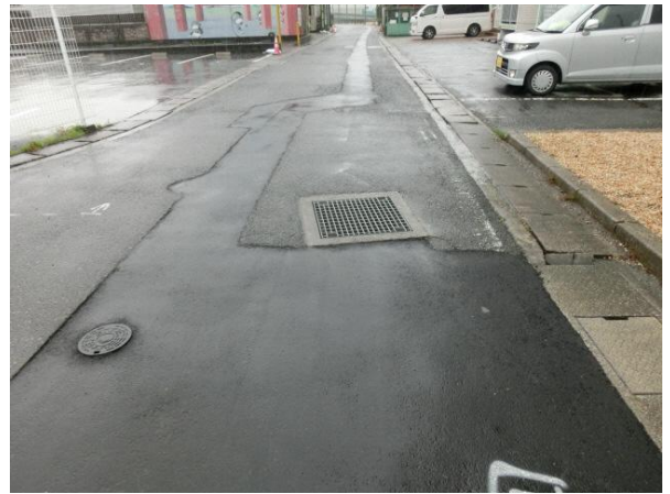
施工状況（舗装復旧）
