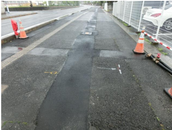
施工状況（舗装復旧）
