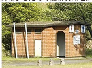
青土ダム駐車場トイレ
