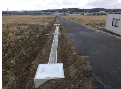
▼用水路の整備
