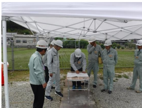
〔 中野浄水場施設更新工事その2 〕
