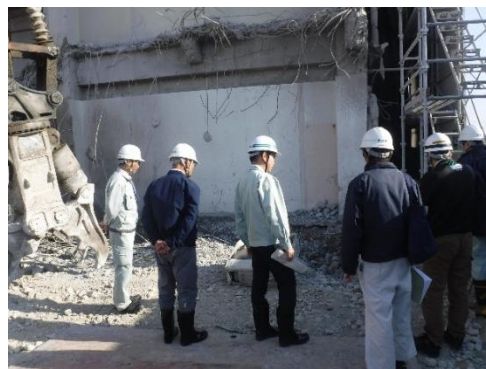
〔 旧水口医療介護センター増築棟解体工事 〕
