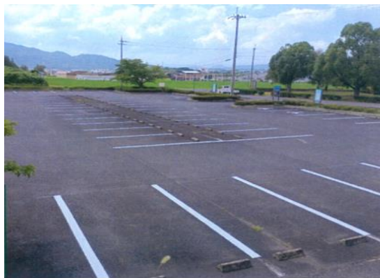
水口スポーツの森駐車場外改修工事
