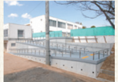
▲佐山小学校バリアフリー工事
