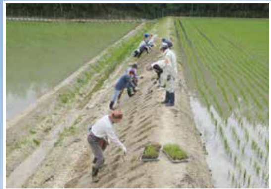
イブキジャコウソウの植付け (耐寒・耐暑性が強く、また被覆能力が高いため 法面の雑草管理に有効)
