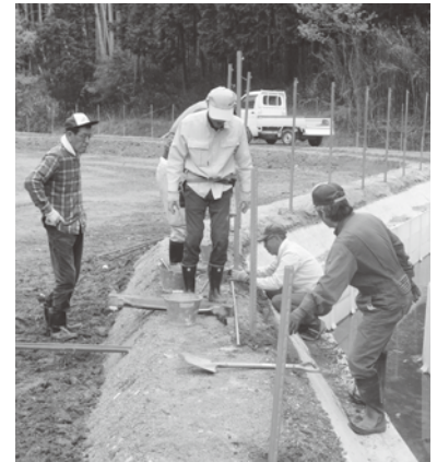
農業組合員による獣害柵設置工事中
