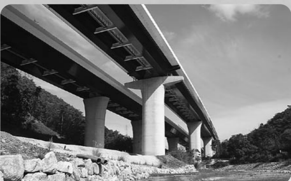
▲工事が進む第二名神高速道路
