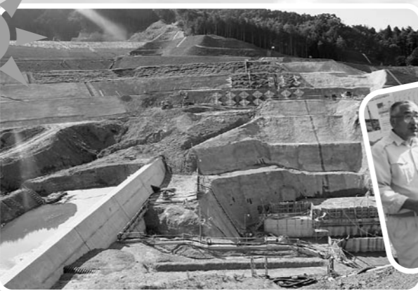
▲着々と工事が進むクリーンセンター滋賀
