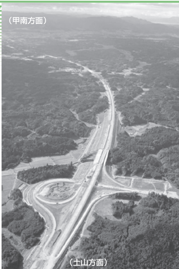
▶ 甲賀土山インターチェンジ付近の様子
