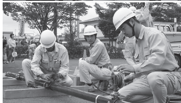
▲生活に欠かせないガス、水道施設復旧訓練
