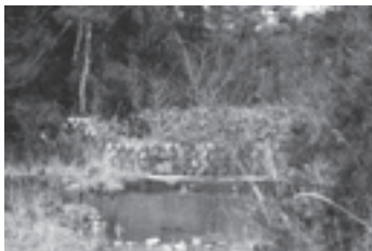
▲下山川2号堰堤
