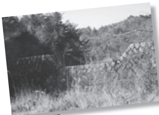
▲下山川3号堰堤
