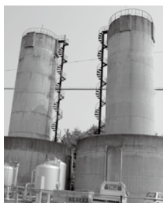
移管された希望ヶ丘水道施設(給水塔)
