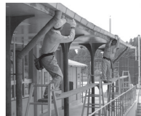
▲施設の修繕作業を行う皆さん（信楽中学校）
