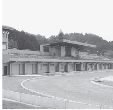
▲工事が進むスポーツの森陸上競技場
