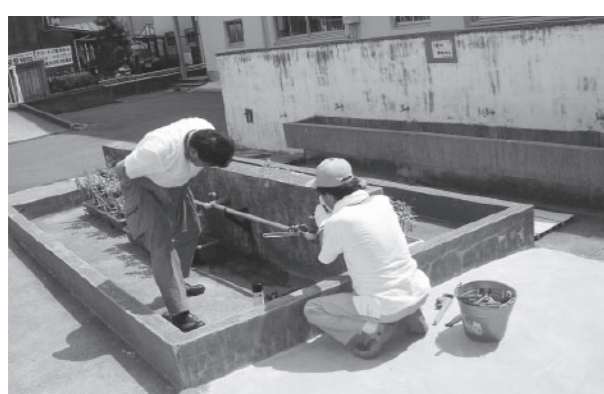
▲施設の修繕作業をする皆さん(綾野小学校)
