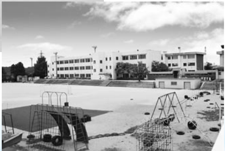
● 現在の貴生川小学校校舎
